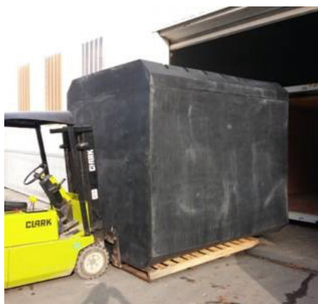
Montaż modułu biologicznego w kontenerze morskim.
