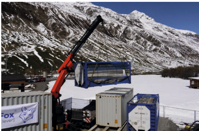
Unload and position Déchargement et positionnement
