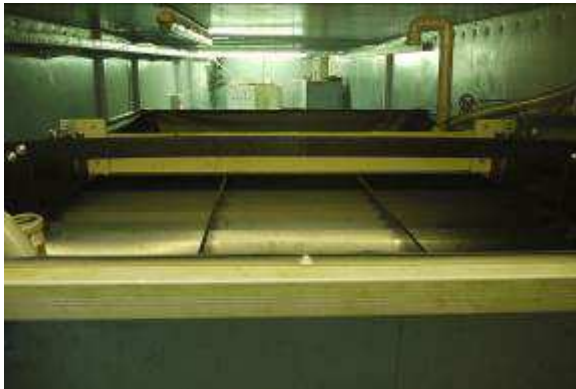
Ansicht von innen Maschinencontainer
