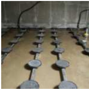
Belüftungssystem
